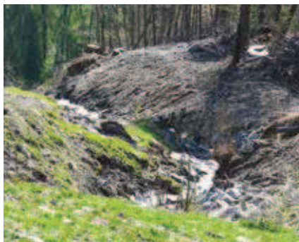
Torrent de la Corniolla entre les Verneys et RC Hérémece: déboisement, reprofilage du lit, drainages et ensemencement.
