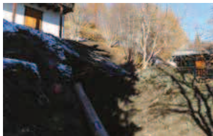
Torrent des Collons Nord: pose de la canalisation de dérivation de crues dans le cadre du PGEE (Plan Général d'Evacuation des Eaux)
