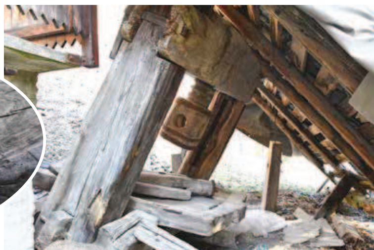
Le pressoir en position périlleuse avant son déplacement.
