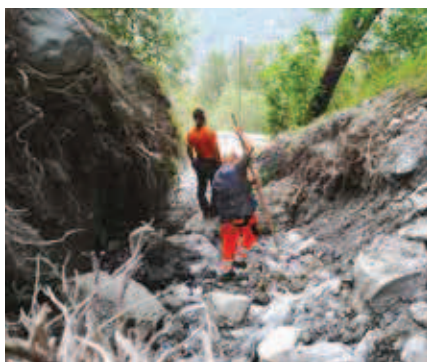
Torrent de la Corniolla: tronçon profondément érodé.
