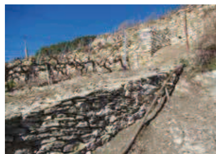
Murs après réfection de mars 2019
