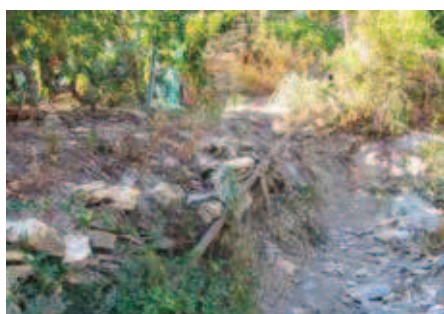
Murs en pierres sèches partiellement effondrés
