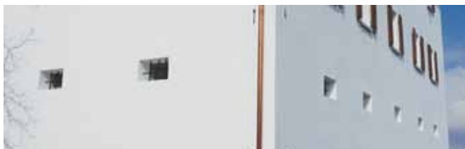
Détails de l'étage de l'entresol
